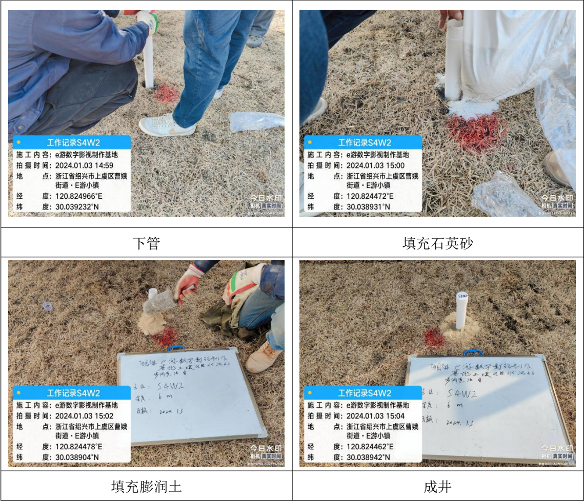
图 5.4-1 现场成井照片
