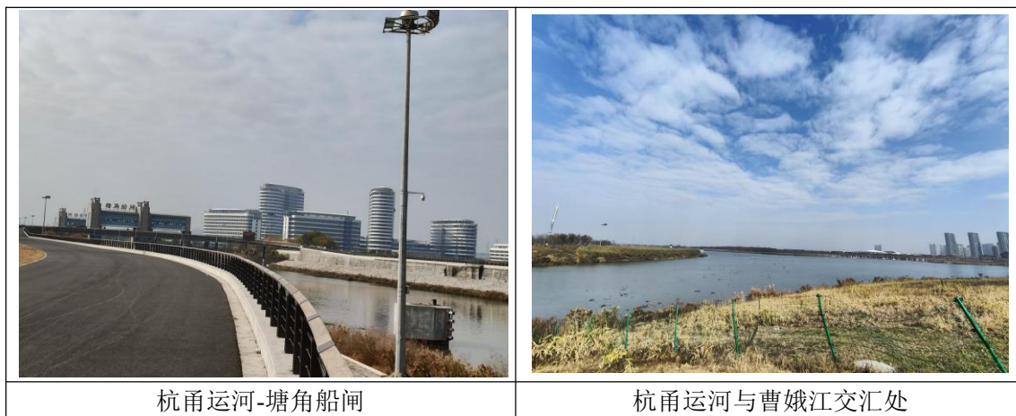
图 3.1-3 杭甬运河现场情况
