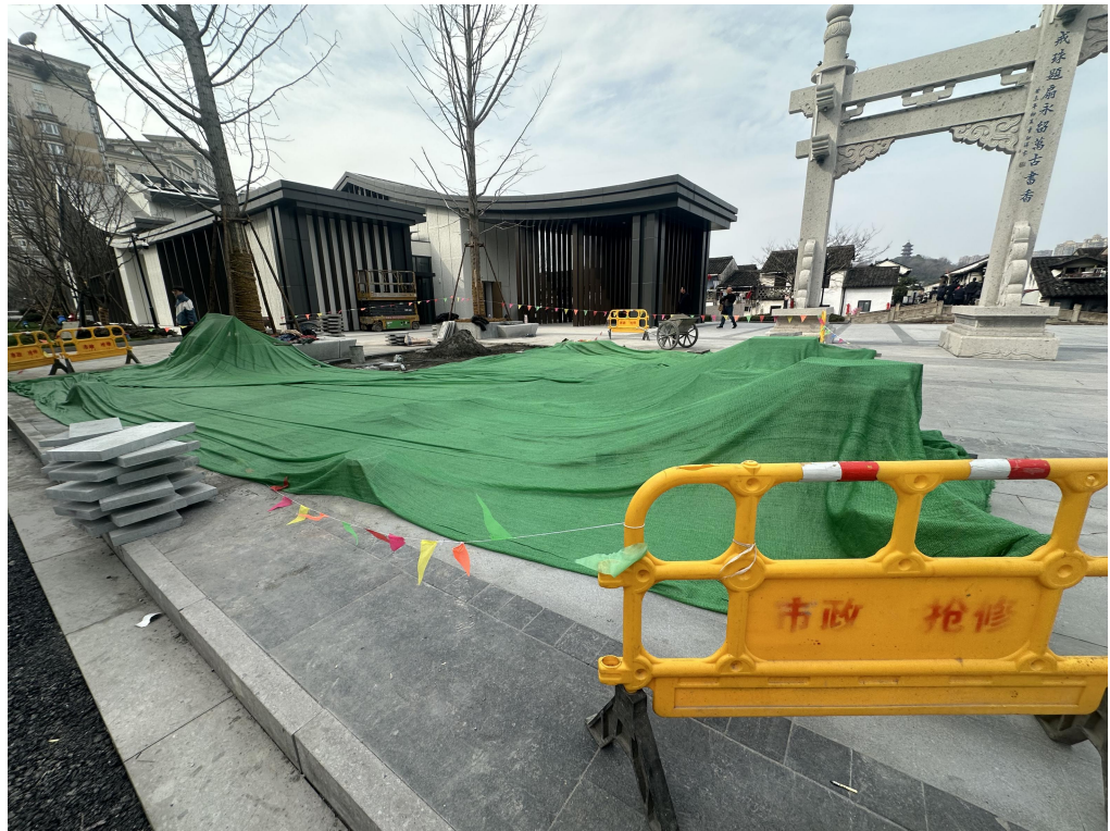
图 7.2 围挡、堆放材料遮挡、喷雾抑尘等措施
