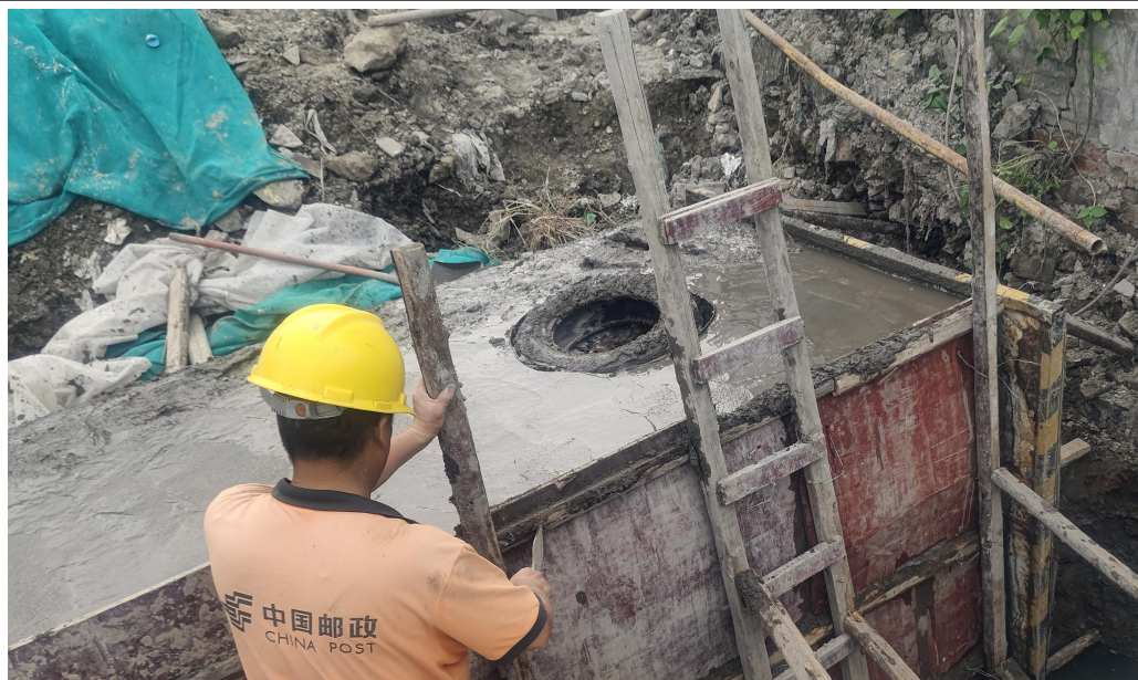
图 7.3 建设隔油池、化粪池等措施
